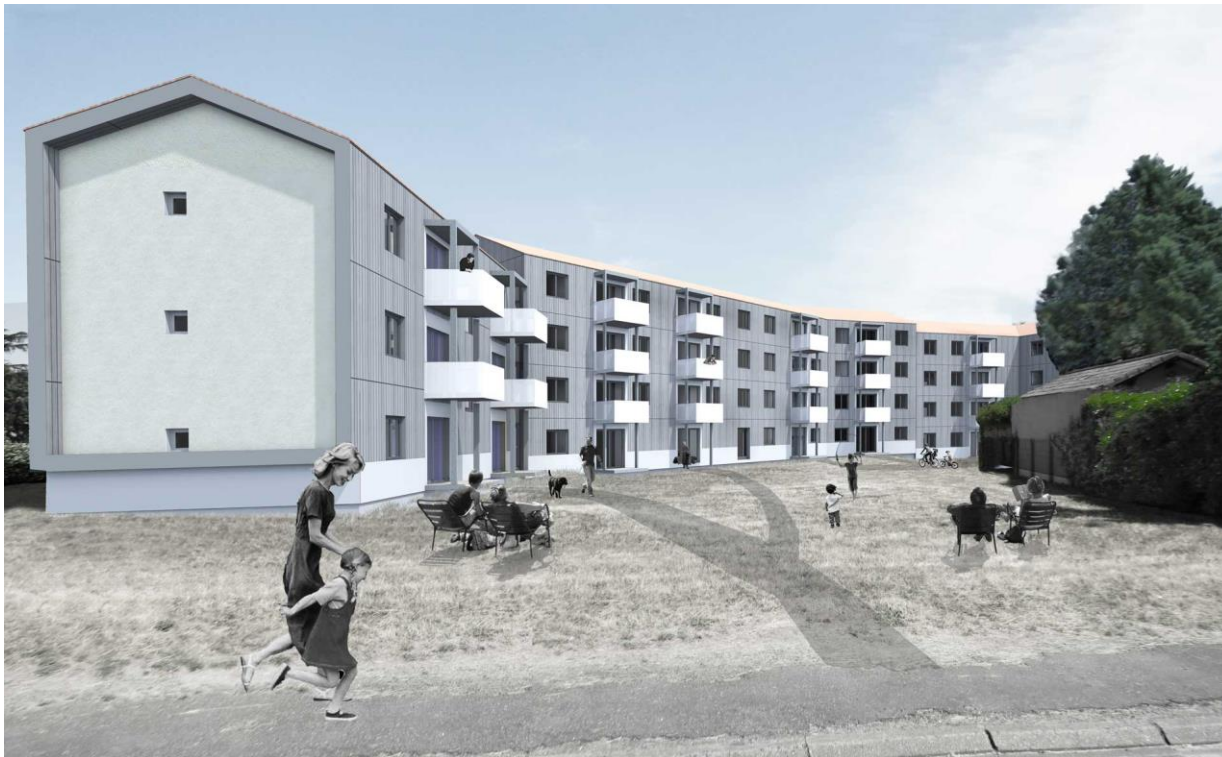
Pignons La Pince 1 : enduit sur isolant
