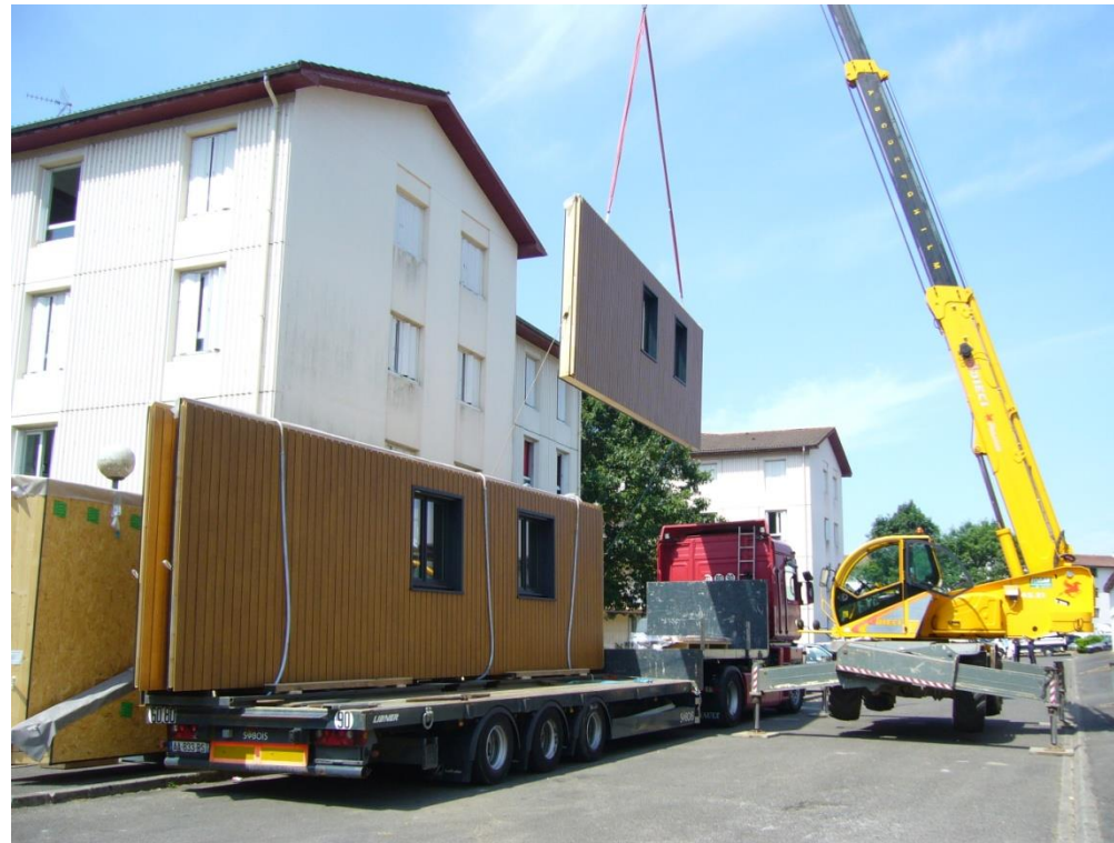
Pose des panneaux à ossature bois
