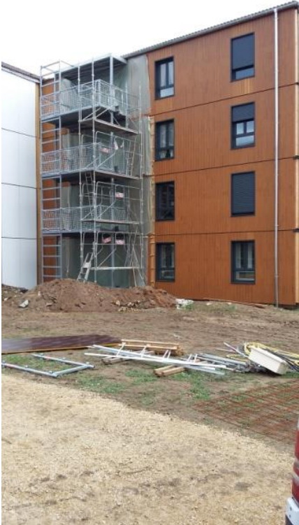
Pose de la structure métallique
