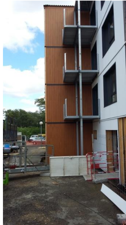
Coulage des dalles en béton
