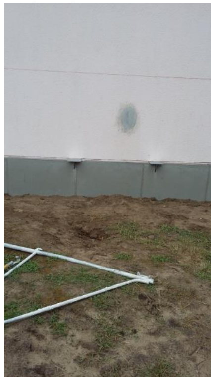
Repérage et pose de la lisse basse Isolation du soubassement
