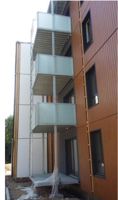
Pose des garde-corps en verre
