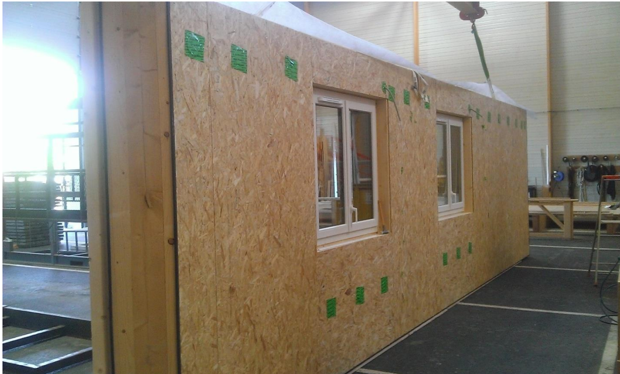
Préfabrication des panneaux à ossature bois
