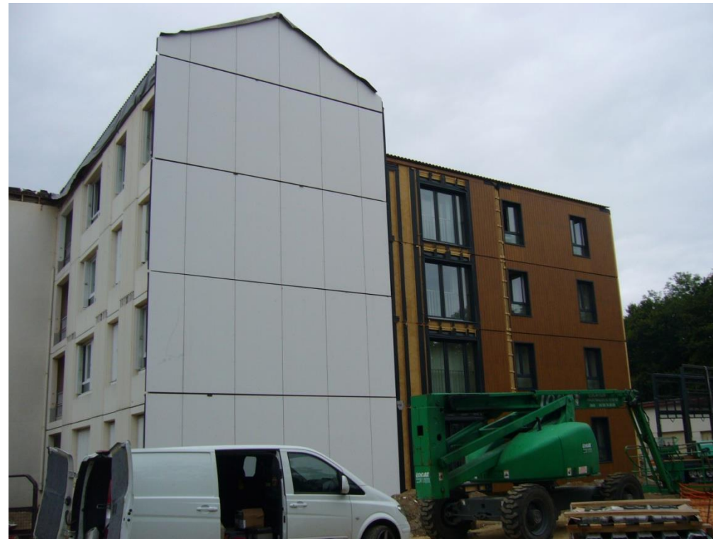
Pose des panneaux à ossature bois
