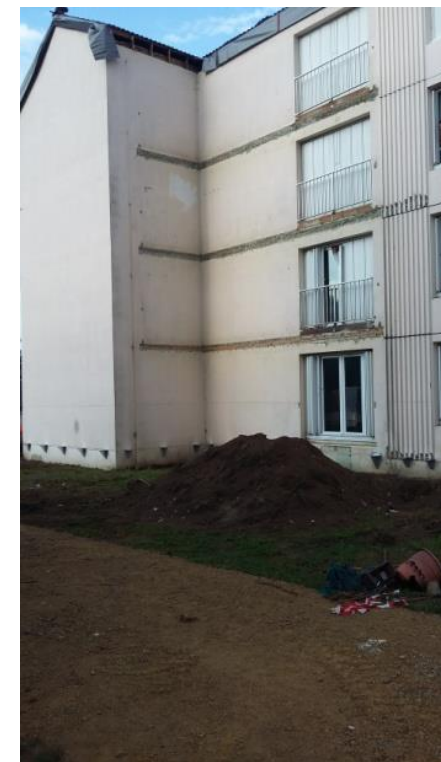
Découpe des balcons et des allèges des loggias Pose des garde-corps de substitution
