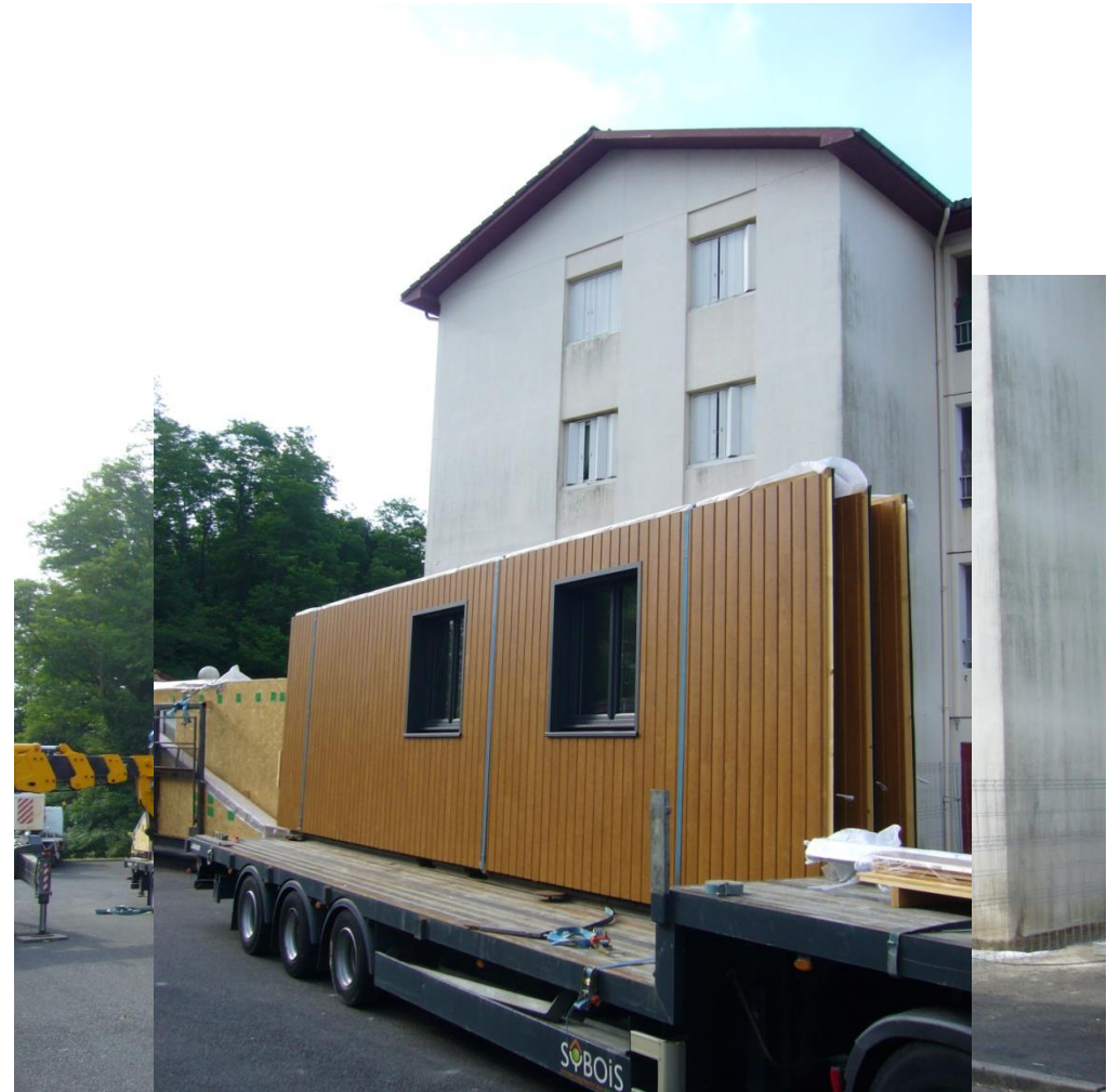
Livraison des panneaux à ossature bois
