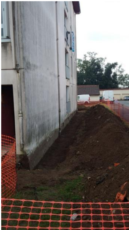
Décaissement en pied de bâtiment
