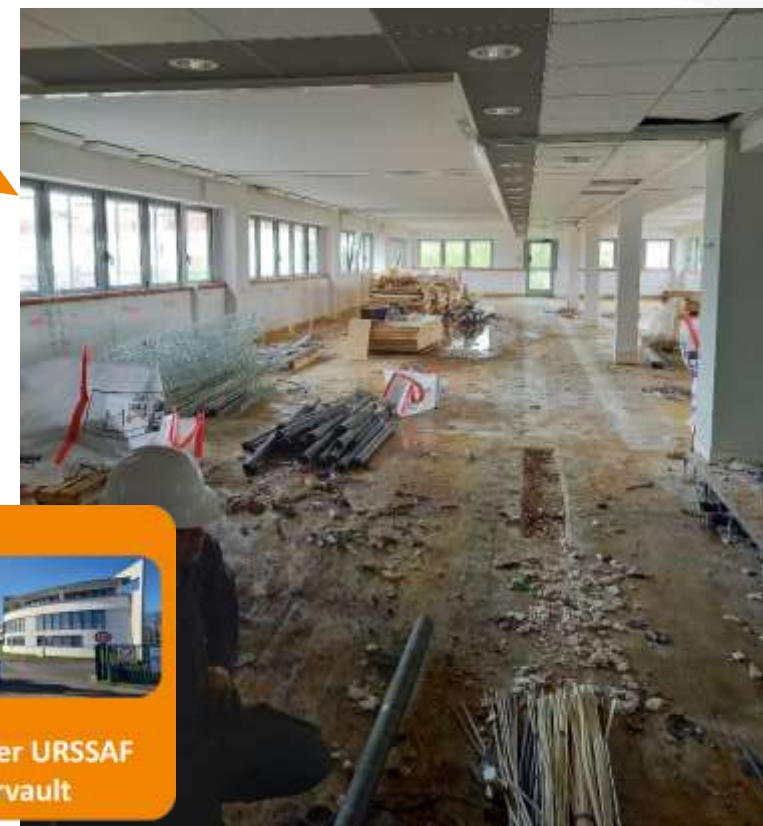
Ch. déconstructions sélectives
