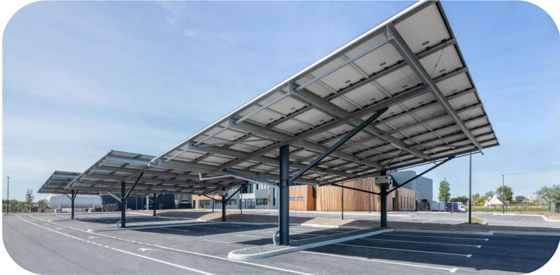
Ombrières de parkings à Penmarc'h (29) Investissement BreizhEnergie
